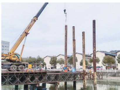
近日,由成都铁路工程总承包有限责任公司承揽,中铁宝桥(南京)建设工程有限公司承建的宝成铁路回龙河大桥桥梁基础冲刷整治工程启动,水害复旧与结构安全加固工作全面展开。通讯员 吴谦 摄
