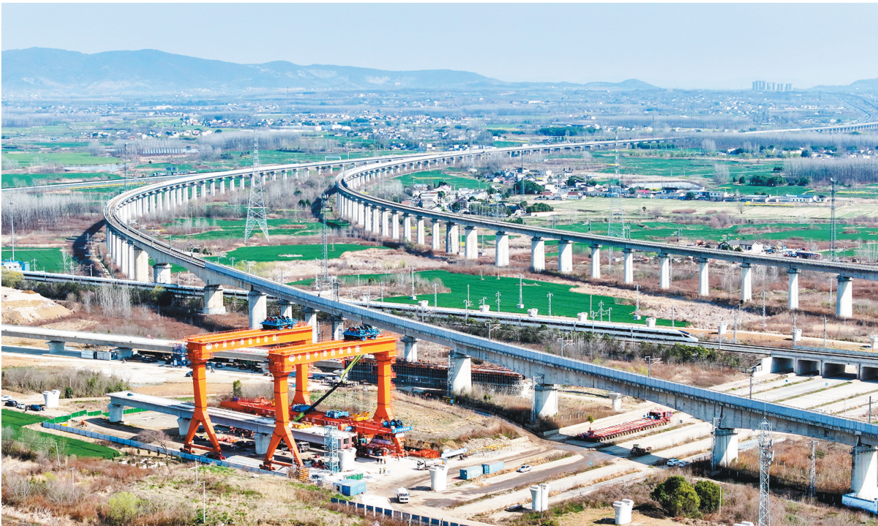
这是3月18日拍摄的中铁四局新建沪宁合高铁合肥枢纽建设现场(无人机照片)。
