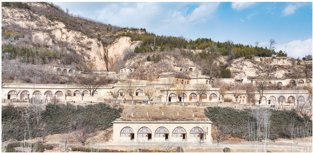
延安工人学校旧址。
