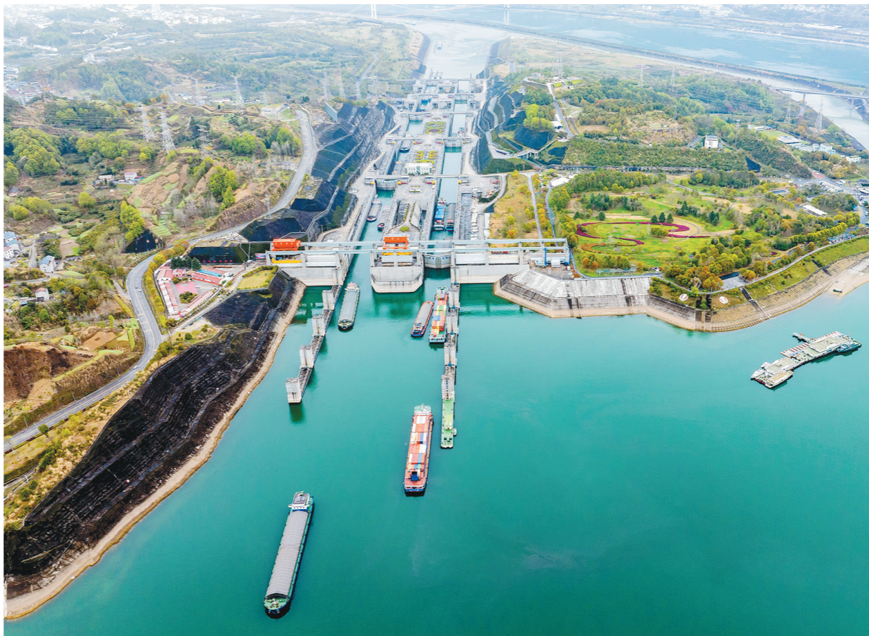
3月29日,在湖北宜昌,船舶有序通过三峡双线五级船闸(无人机照片)。据长江三峡通航管理局统计数据显示,截至3月28日,三峡船闸累计运行21.2万闸次,通过船舶106.5万艘次,过闸货运量达22亿吨。
