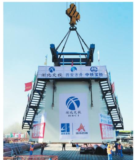
3月25日,由中铁宝桥扬州公司参建的武松高壮观音寺长江大桥索塔T28段精准吊装就位,观音寺长江大桥南岸索塔圆满封顶。标志着这座主跨1160米的世界斜拉桥建设迈入钢主梁施工新阶段。通讯员 白路腾 杨龙权 摄
