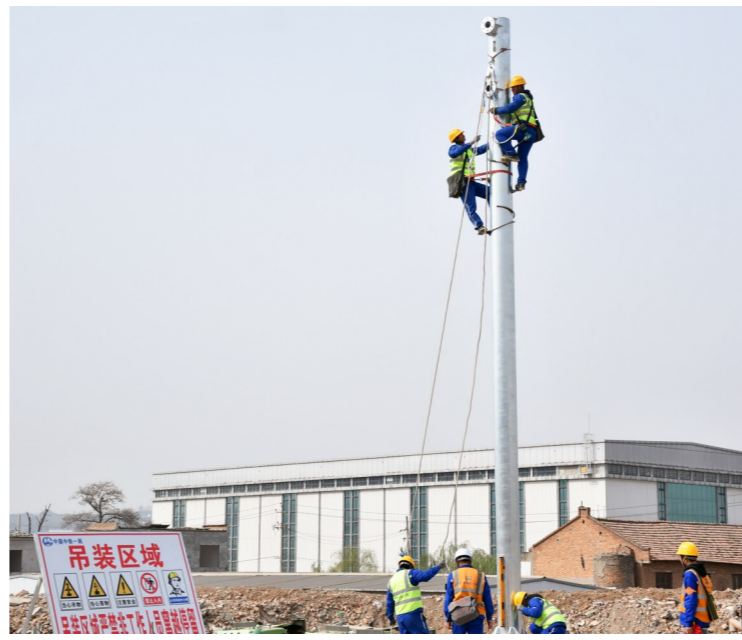
工作人员进行西安东站接触网钢柱组立。
