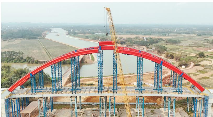
近日，由中铁工业旗下中铁宝桥西南分公司参建的平陆运河QL4标东坝村大桥主拱顺利合龙。该大桥是中铁宝桥平陆运河项目中的第一座全桥合龙桥梁，标志着项目建设取得重大阶段性成果，为后续其他桥梁建设提供了宝贵经验和借鉴。
