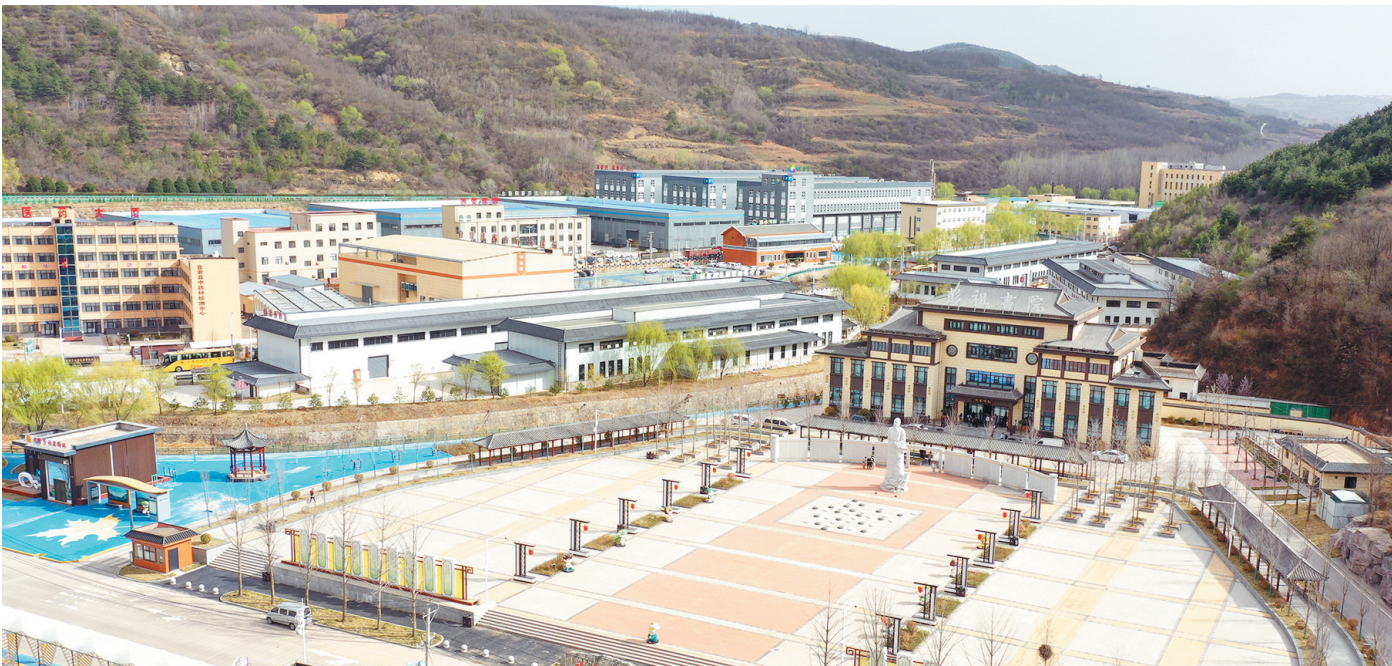
记者近日拍摄的铜川市宜君县科技工业园区。(无人机照片)
