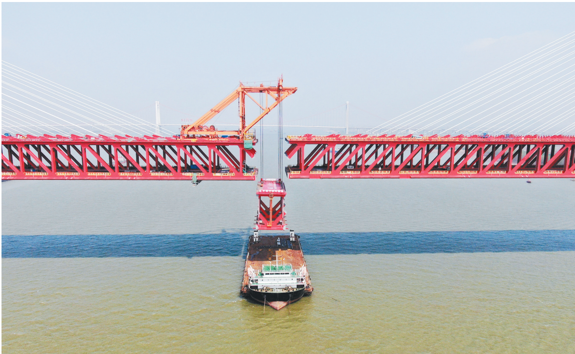
4月17日,随着合龙钢梁焊接完成,由中铁工业旗下中铁山桥、中铁宝桥、中铁科工、中铁九桥联合打造的世界首座单跨超千米的三塔斜拉桥——巢马城际铁路马鞍山长江公铁大桥顺利合龙,标志着这座“超级工程”主体施工基本完成,为2026年9月正式建成通车奠定了坚实基础。
