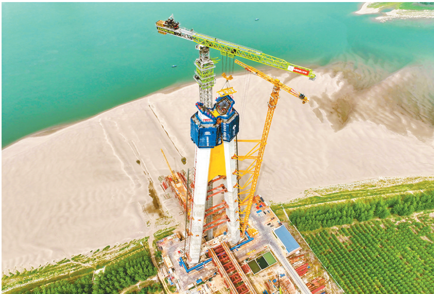
5月6日，由中铁宝桥集团扬州公司参建的武松高速观音寺长江大桥主塔T28节段精准吊装就位、实现圆满封顶。
