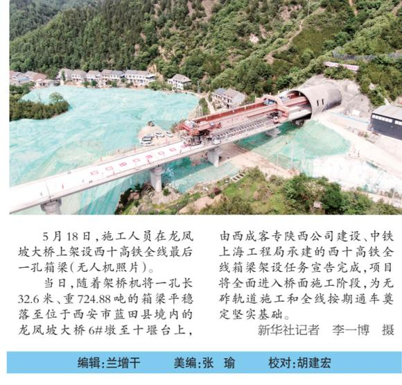
5月18日，施工人员在龙凤坡大桥上架设西十高铁全线最后一孔箱梁(无人机照片)。当日，随着架桥机将一孔长32.6米、重724.88吨的箱梁平稳落在位于西安市蓝田县境内的龙凤坡大桥6#墩至7#墩台上，由西成客专陕西公司建设、中铁上海工程局承建的西十高铁全线箱梁架设任务宣告完成，项目将全面进入桥面施工阶段，为无砟轨道施工和全线按期通车奠定坚实基础。新华社记者 李一博 摄
