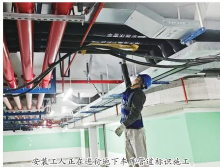
安装工人正在进行地下车库管道标识施工。
