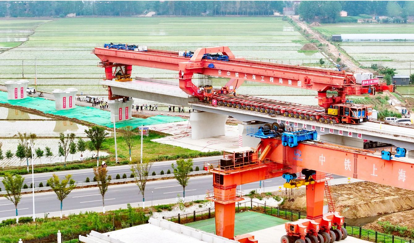
6月21日,在滁宿高铁郅城沭河特大桥施工现场,中铁上海局工作人员在进行箱梁架设(无人机照照片)。当日,滁(坊)宿(迁)高铁山东临沂段首根箱梁架设成功,正式进入线上架梁施工阶段。据悉,滁宿高铁是京沪高铁辅助通道的重要组成部分。 新华社记者 郭绪雷 摄
