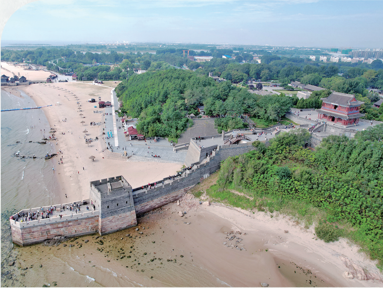
2024年9月19日拍摄的河北省秦皇岛市山海关区“龙头”景区(无人机照片)。
