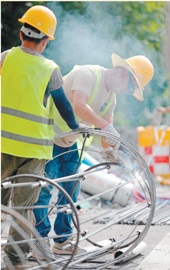
→7月11日，在汉中市南郑区阳春镇大碗及水产品深加工研发生产项目现场，工人正在施工。 通讯员 何祥弘 摄
