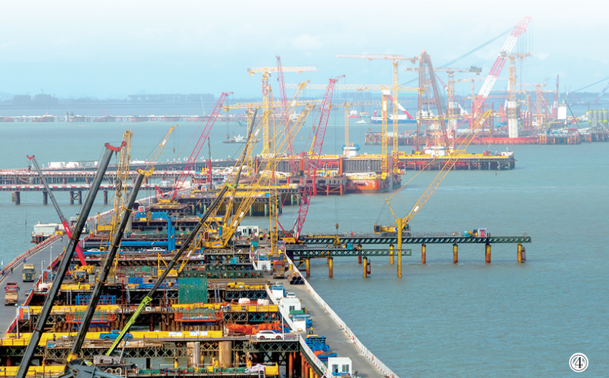
①甘肃张掖市高台县职业中等专业学校机器人焊接实训教室内，老师（左一）在指导同学们实训。 王将 摄（影像中国） ②哈尔滨职业技术大学毕业生张安贤在进行转轮加工。 受访者供图 ③白鹤滩水电站。 张洪科 摄（影像中国） ④厦金大桥（厦门段）海上桥梁大规模装配化施工现场。 新华社记者 魏培全 摄
