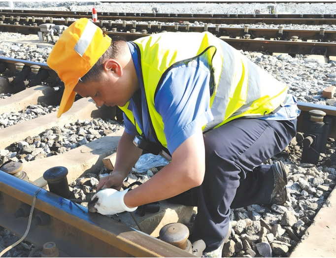
高山桐在股道检修减速顶。
