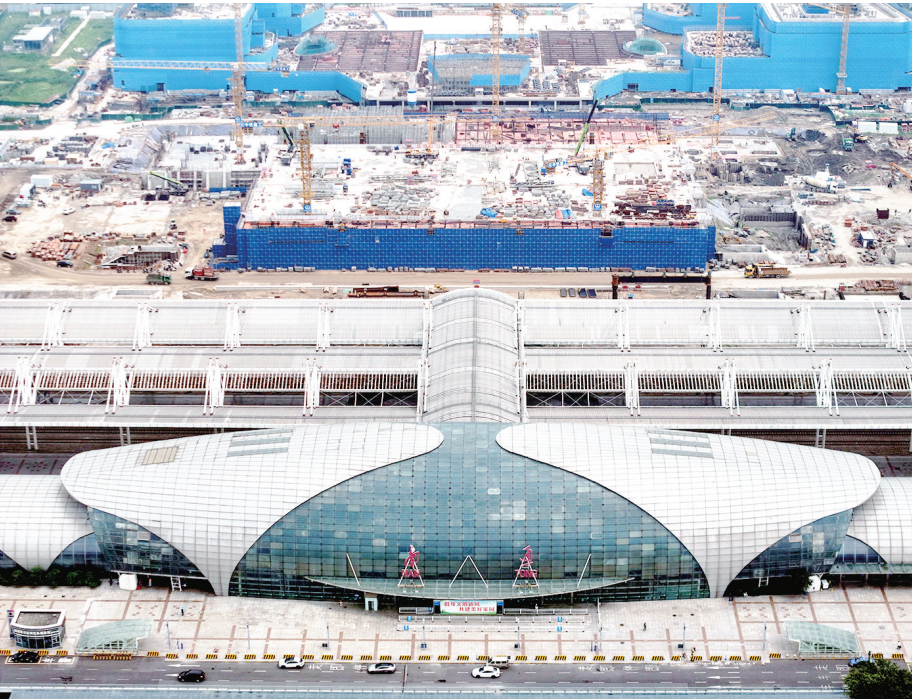
这是8月6日拍摄的新建上海至南京至合肥高铁南通站站房建设现场(无人机照片)。当日,由中铁建工承建的新建上海至南京至合肥高速铁路南通站站房钢结构首节桁架吊装完成,标志着项目正式进入钢结构安装新阶段。据介绍,新建南通站站房及相关工程是沪渝蓉高铁的重要组成部分,站房建筑面积约55000平方米,建成后站场总规模达3场9台20线,对助力区域内交通融合发展、推动长三角更高质量一体化发展等具有重要意义。新华社记者 季春鹏 摄
