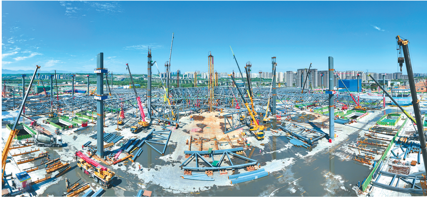
建设项目鸟瞰。(无人机照片)
