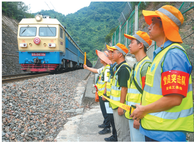
作业人员正在下道避车。
