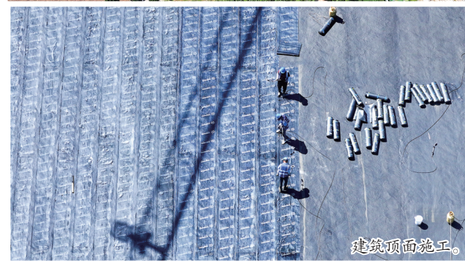
建筑顶面施工。
