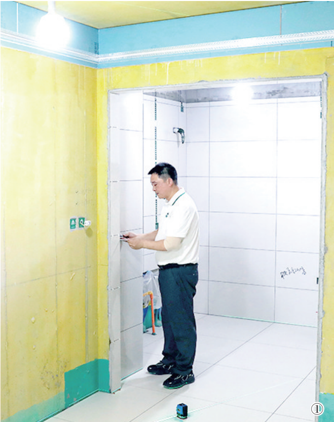
①席峰正检验墙角平整度。
