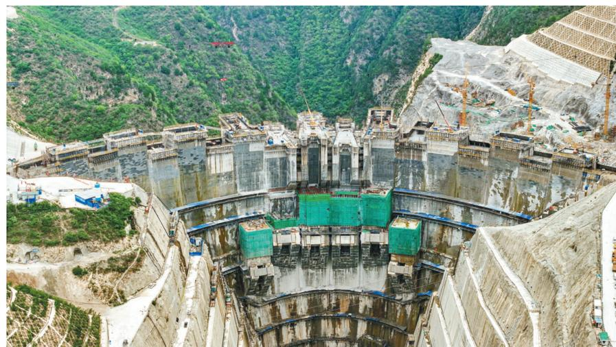
7月8日，建设中的东庄水利枢纽工程(无人机拍摄)。近日，随着19号坝段013仓封顶浇筑完成，东庄水利枢纽大坝混凝土浇筑首仓顺利到顶，标志着工程建设取得阶段性成果，为年底实现下闸蓄水，2026年底全面建成投运奠定了基础。
