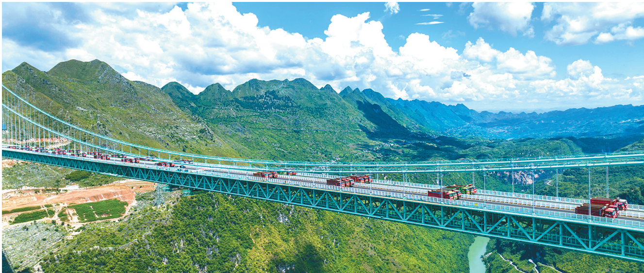
8月25日拍摄的贵州花江峡谷大桥荷载试验现场(无人机照片)。
