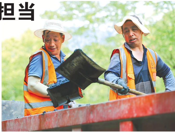
高温下,职工铺筑沥青混凝土路面。
